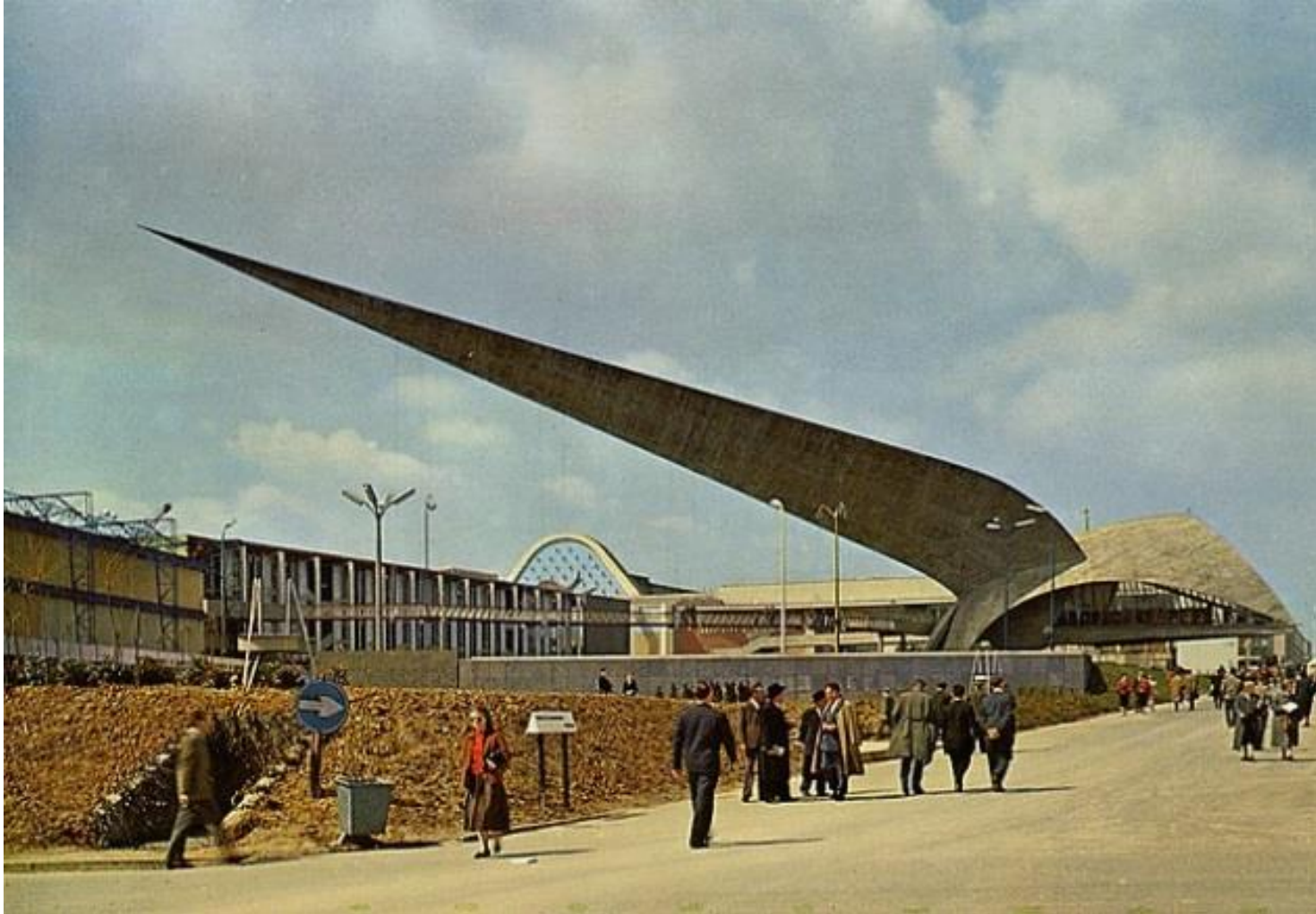
La flèche du Génie Civil, architecte Jean Van Dooselare, sculpteur Jacques Moeschal, ingénieur André Paduart, 1958, Exposition Universelle de Bruxelles (aujourd'hui détruite)
