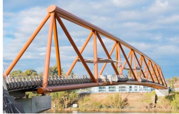
Pour concevoir ce pont, nous nous sommes inspiré des ponts triangulés. En effet, cette structure permet un contreventement structural avec l'utilisation des triangles. Cette technique nous a permis de réaliser un pont de 87 cm et de 76cm de portée.
