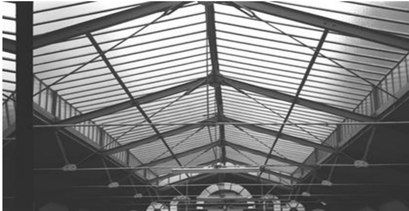
Vue en élévation d'une ferme Polonceau
