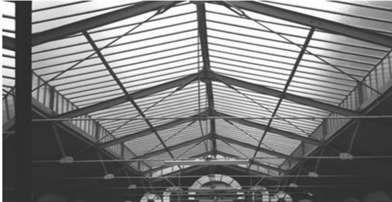
Vue en élévation d'une ferme Polonceau
