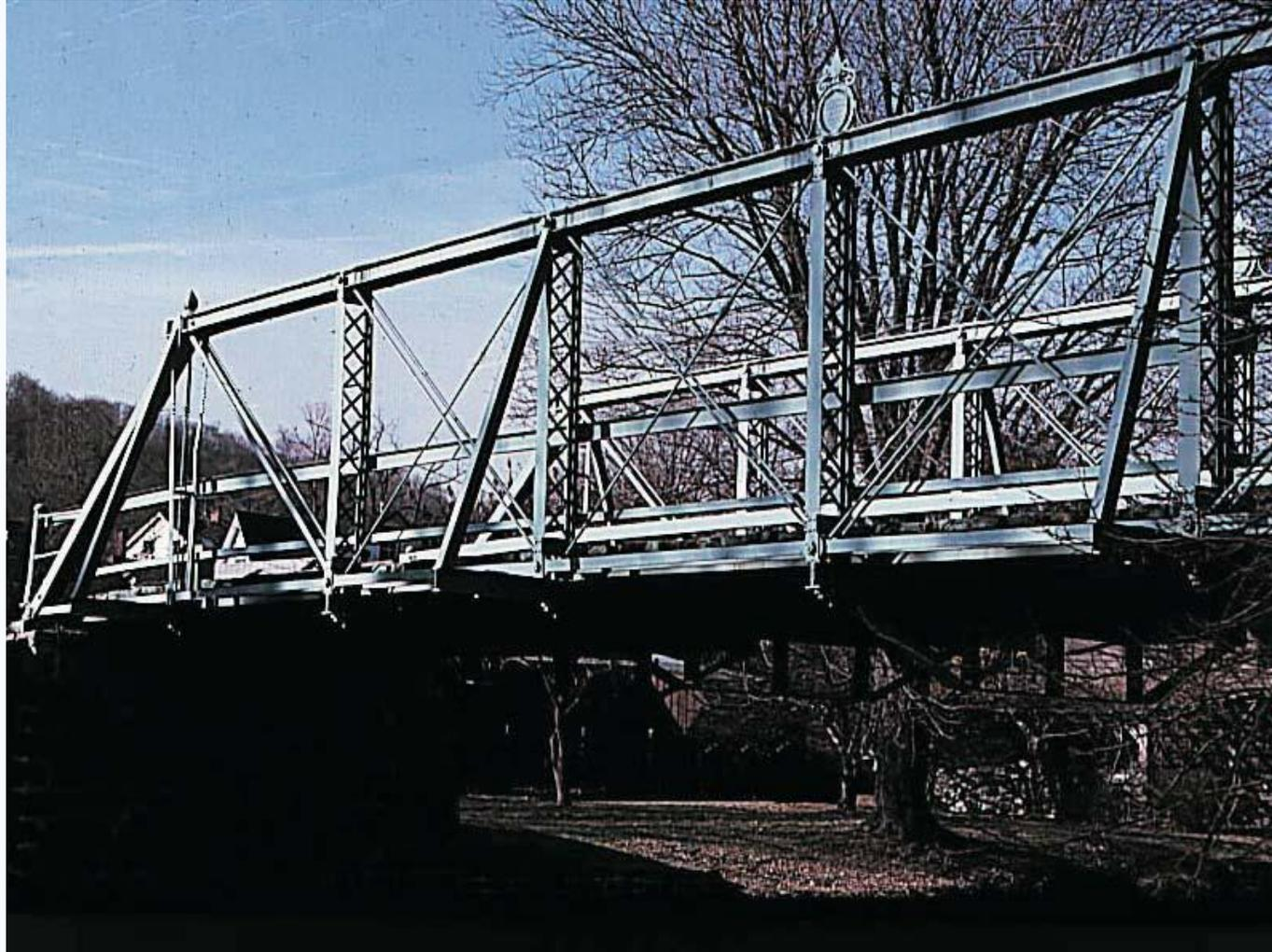
Ce pont du XIXème siècle est composé de deux poutres treillis bidimensionnelles en acier. A cette époque, la méthode de détermination des efforts dans les éléments passait par une résolution des nœuds que nous allons découvrir.
